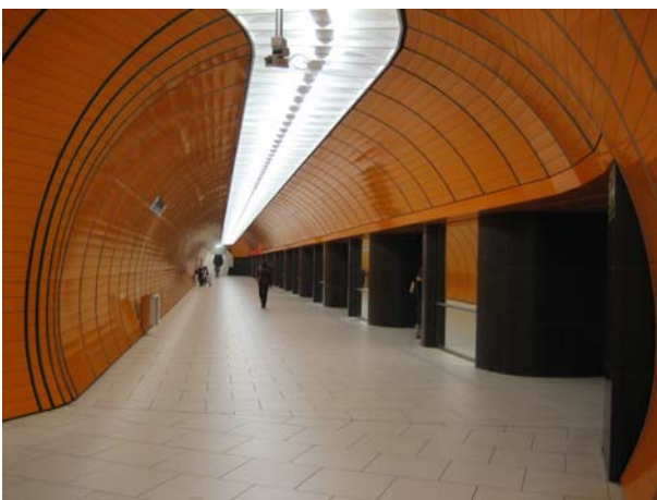
Wand- und Deckenverkleidungen, Leuchtenkonstruktionen
